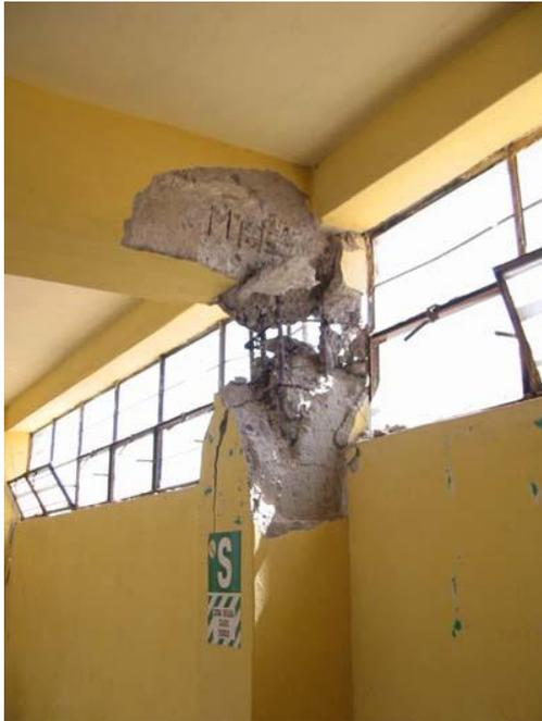
**Foto 15:** Foto de daño por efecto de columna corta en el terremoto del 23 de Junio del 2001 en el Sur del Perú – World institute for Disaster Risk Managment.
