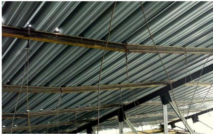
**Foto 26:** Estructura oxidada de la cubierta de un coliseo en Argentina. Fuente: Diario Andino
