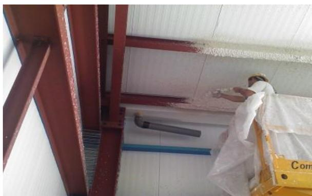
**Foto 13:** Colocación pintura anticorrosiva. Fuente: Protecwork's.
